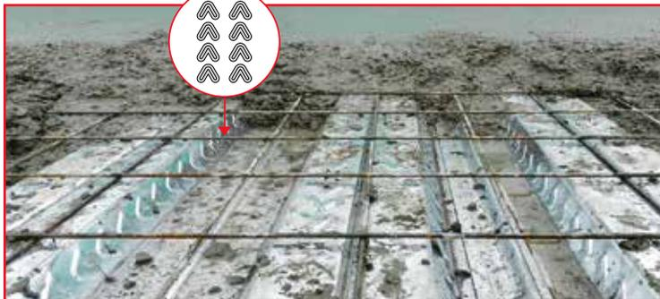
Una vez que el hormigón alcanza su resistencia, la placa **FERRODECK®** actúa como acero de refuerzo inferior o positivo de la losa.
